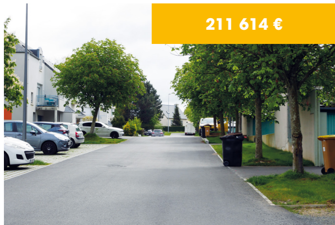
Réaménagement du quartier Pasteur- 2 e phase
