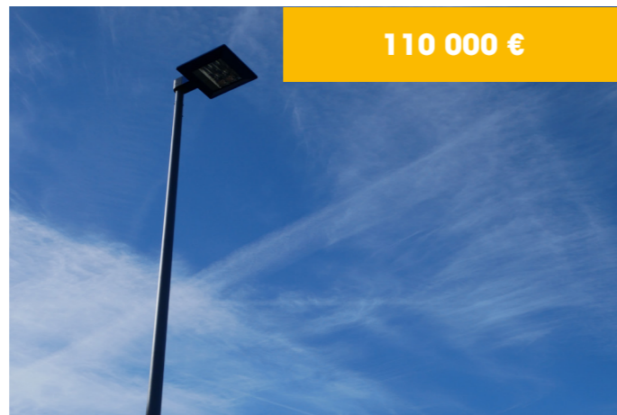
Modernisation de l'éclairage public
